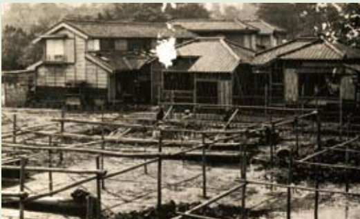
明治期の天田脱脂綿工場。手前は脱脂綿の野天乾燥場
